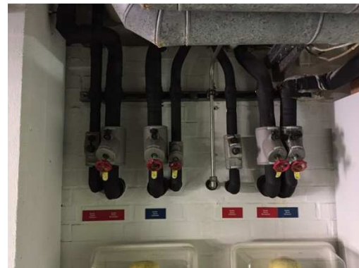
Erneuerte Abgänge mit Armaturen
