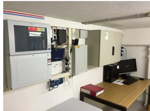
Erneuerte SIBE Anlage
