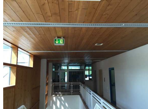
Beleuchtung Zugang zur Umkleide
