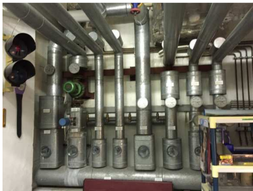
Verteiler „RLT Zentrale West“
