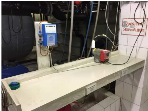
Dosieranlage FL und PH Anlage LSB
