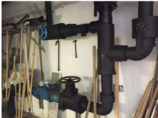
Hauseinführung und Wasserzählung
