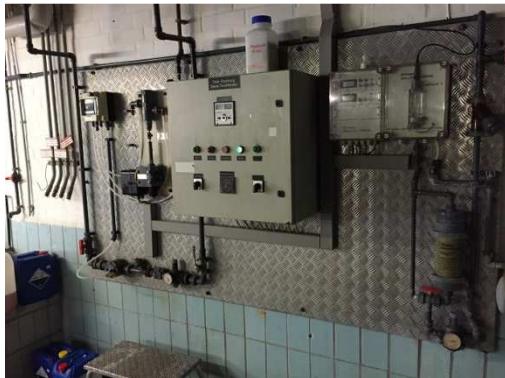
Mess- und Regelanlage Tauchbecken
