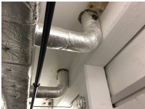
Erneuerte AW-Leitung Zuluftkästen
