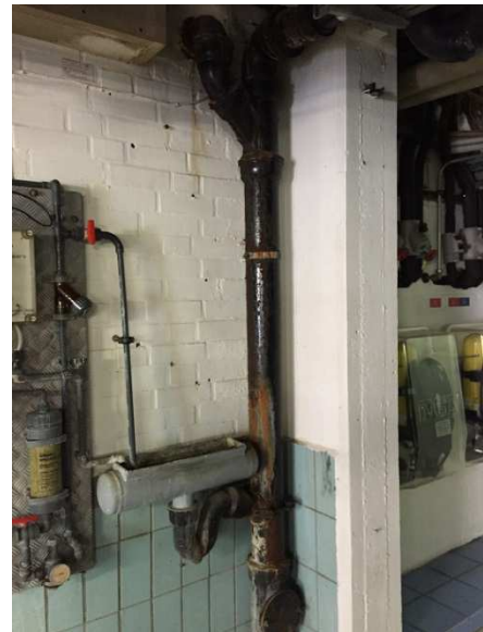
„Alte“ AW-Leitungen aus Guss
