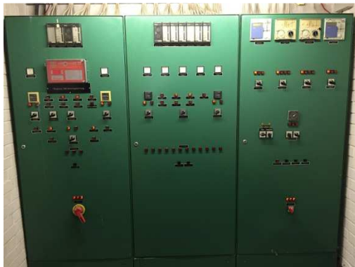
Alter Schaltschrank MSR Lüftung
