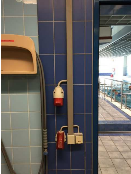
Installationen auf der Badeebene
