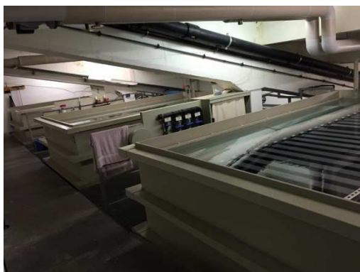
Anschwemmfilter Sport Halle / Außen
