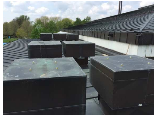
Ablüfter auf dem Dach
