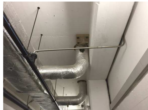
Anschlussleitungen zu den Kästen
