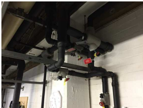
Erneuerte Installation und Bereichsabgänge
