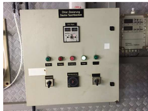
Altbestand Steuerschrank Tauchbecken
