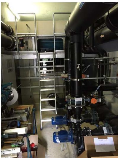
Saugfilter Anlage Herrenbecken
