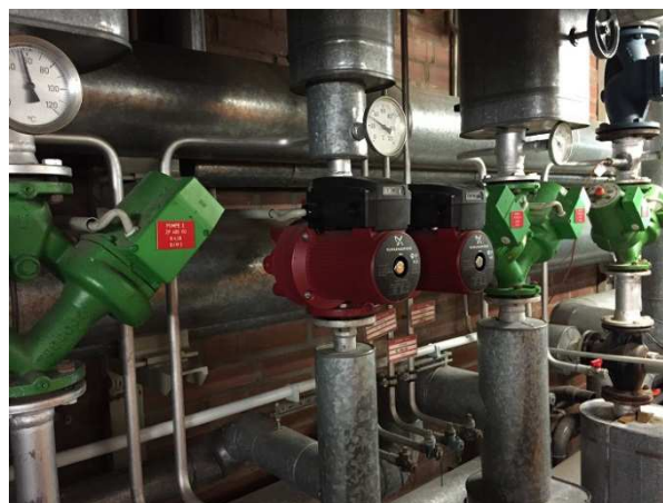
Neue und alte Pumpen Verteiler „Nord“
