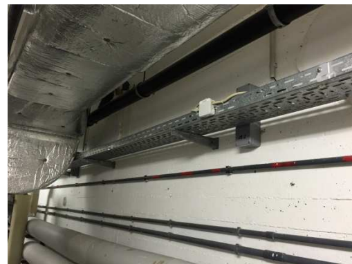
Neuinstallation im Keller
