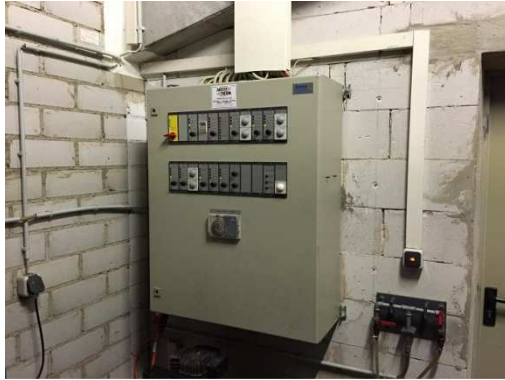
Alter Schaltschrank MSR Lüftung
