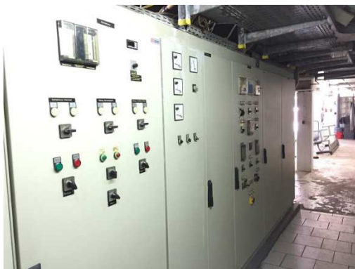
Alter Schaltschrank MSR Heizung
