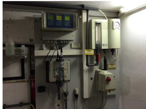
Mess- Regeltechnik, Gasdosierung Anlage LSB
